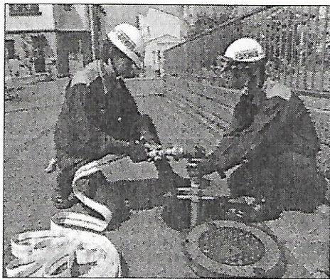
図1 スタンドパイプ設置の様子
